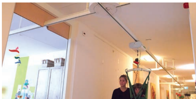
Monorailsysteem met rotonde en brandwerende deurdoorvoer.
