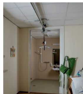
Monorail in combinatie met traverse-systeem.
